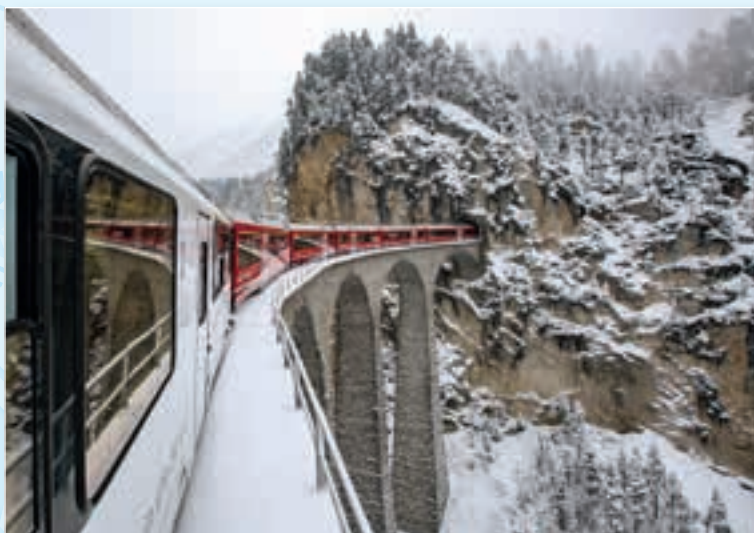
Landwasserviadukt der Rhätischen Bahn bei Filisur. Foto: Jan Geerk
